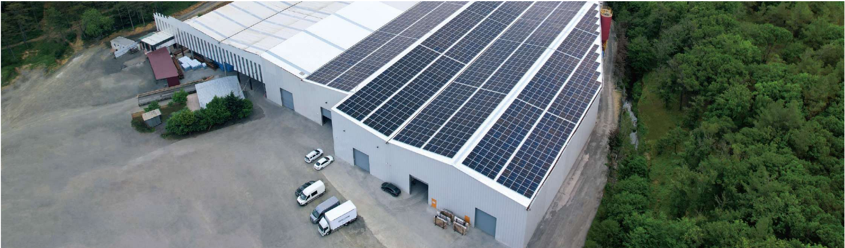
09 Energiekostenreductie voor mineraalwaterfabriek Turkije, 900 kW KSG-120CL-M0
